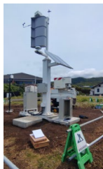
施工写真 (1日で完成)
