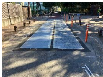
舗装式太陽光パネル設置場所
