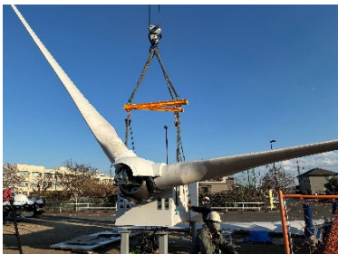
設置工事の様子
